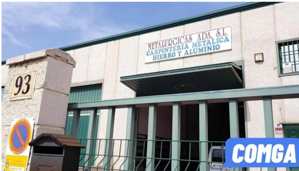
Metalúrgicas ada exterior
